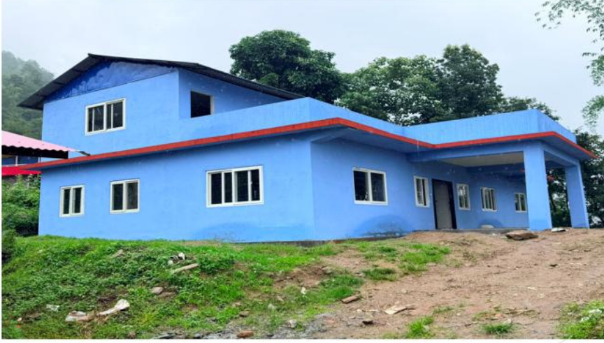
निर्माण सम्पन्न स्वास्थ्य भवन वडा नं ४
